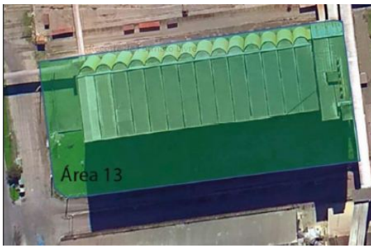
Figura 1 - Silo Público Vertical ("Silão" ou Área 13) Fonte: PDZ do Porto de Paranaguá (2018)
